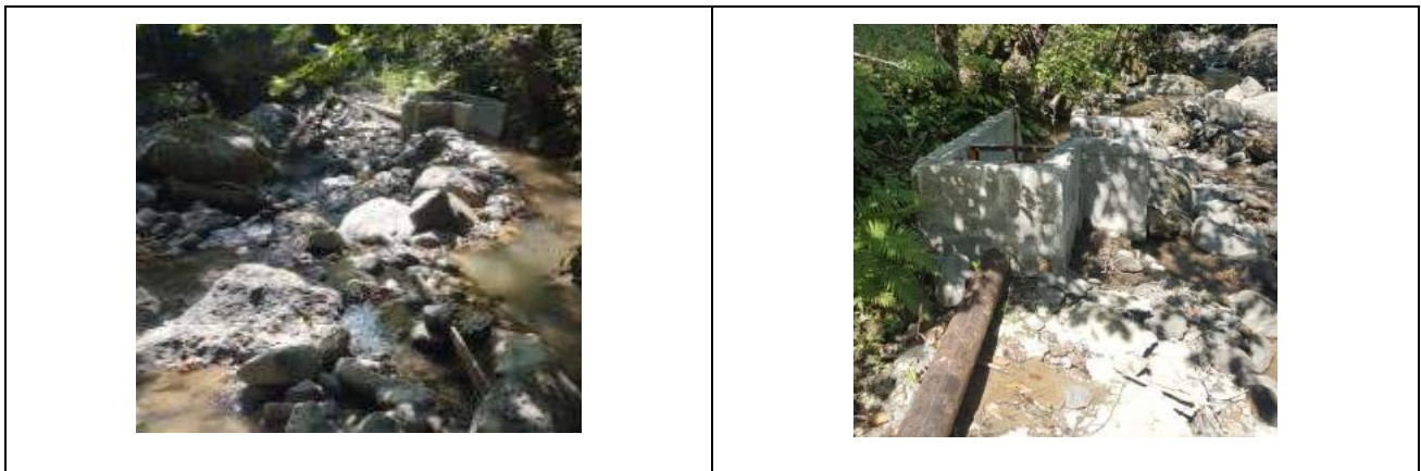
სურათი 9.3.15.4-1; სოფ. ბეგოშვილების სარწყავი სისტემის სათავე ნაგებობის და არხის არსებული მდგომარეობა
