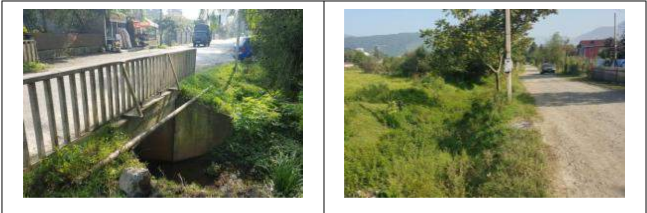
სურათი 6.3.1.2-1; სოფ. ერგეს [2] არხთან მისასვლელი საავტომობილო გზა
